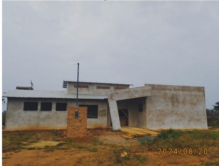
Fotografia 3 - Creche em construção no PA Nova Baixa Verde em 2024
