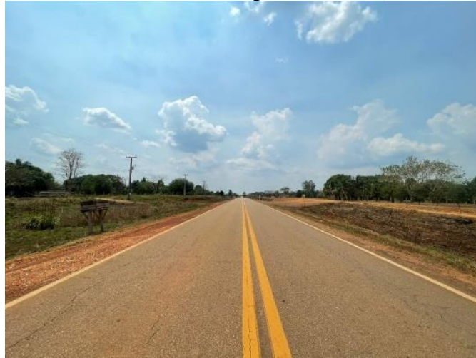
Fotografia 1 - Acesso ao Assentamento pela BR 317 (sentido a Boca do Acre)
