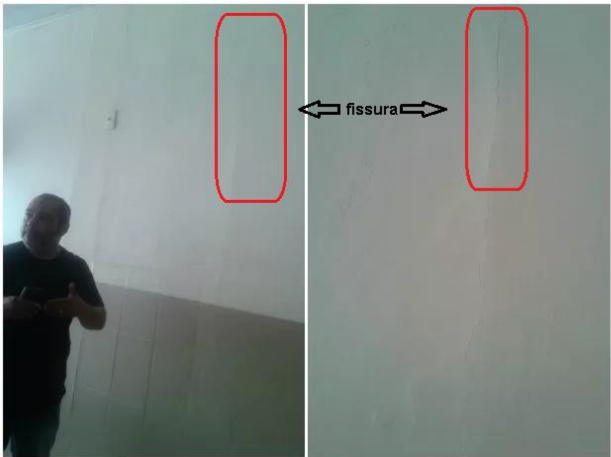
Figura 18. Fissura em prédio de Igreja causada por evento sísmico
